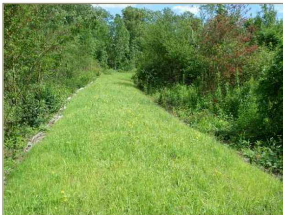
exemple de chemin circulaire par les engins d'entretien, en engazonnement renforcé
