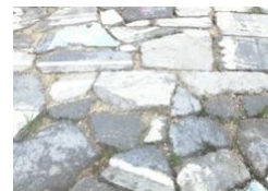
Maçonnerie paysagère en béton déposé et découpé
