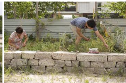
Opus incertum pose sèche ou scellée pierre de béton de réemploi (La Fabrique du Clos, Bellastock – Stains)
