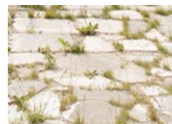
Opus incertum pose sèche ou scellée pierre de béton de réemploi La Fabrique du Clos, Bellastock - Stains
