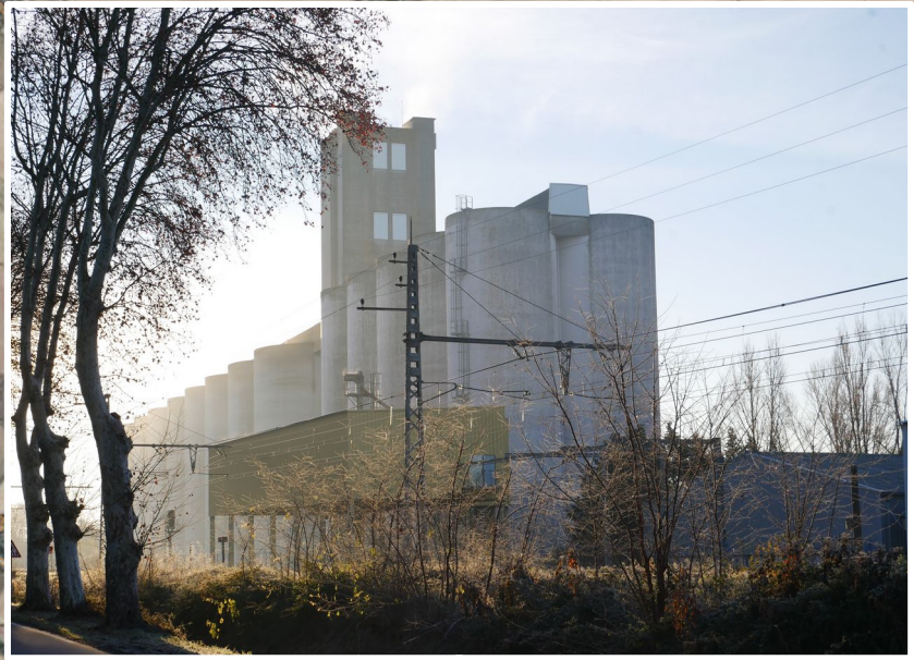
silos à grains de Baziège
